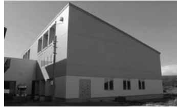
▲完成した青苗小学校体育館
