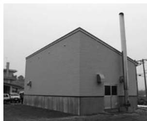
▲青苗小学校チップボイラー
