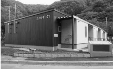
▲新築された町営住宅
