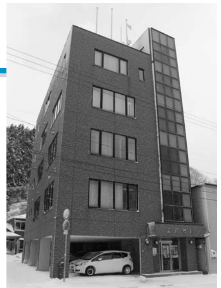
▲ 避難場所となった工藤ビル
