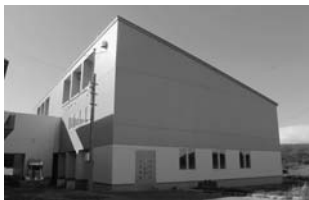
▲ 青苗小学校屋内運動場完成
