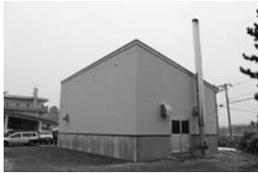
▲ チップボイラー完成
