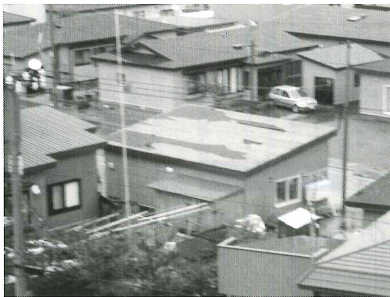
▲11月9日 青苗地区を竜巻が襲い、屋根が飛散するなどの被害
