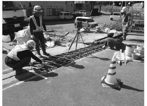
奥尻地区の橋梁修繕工事の様子
