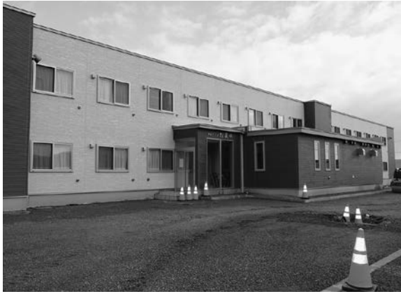
▲増築工事を終えた松風寮
