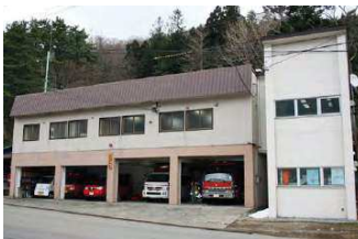
■ 既存奥尻消防庁舎
