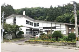
■ 既存奥尻町議会庁舎
