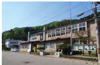
■ 既存奥尻町役場庁舎
