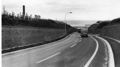
調査後に完成した道路
