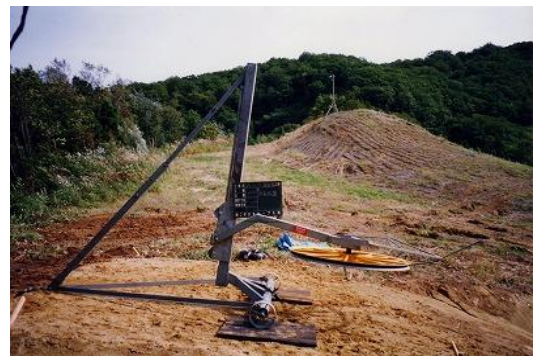
簡易リフト設置状況 平成4年
