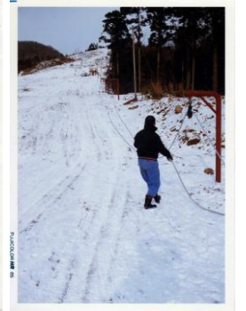
ロープ塔設置状況
