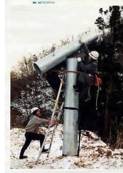
照明灯設置状況
