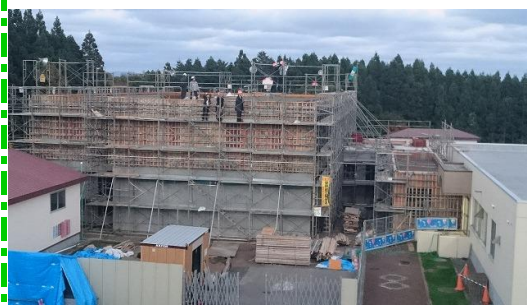
建設中の新校舎
