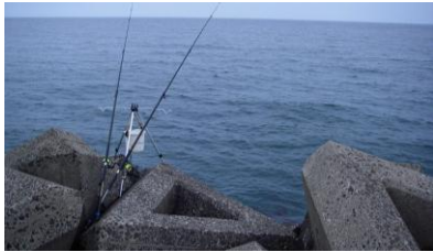
危険な例 奥尻港外防波堤
