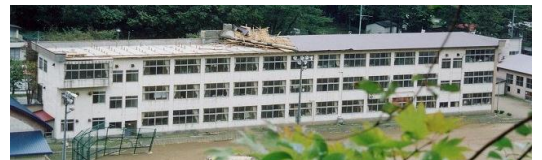
台風18号で屋根が飛んだ奥尻小学校 平成16年
