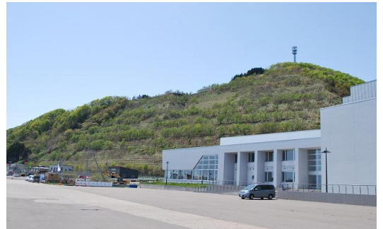
奥尻町海洋研修センター(字奥尻314地先)
