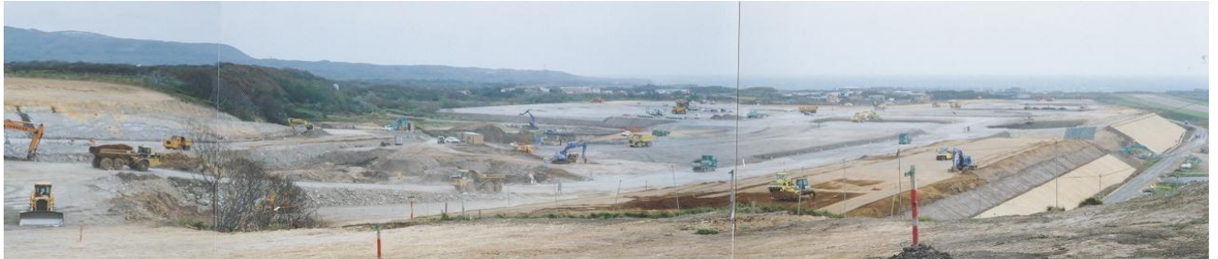
第1期拡張工事 平成14年頃
