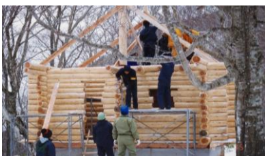
雪の中、建設は進む
