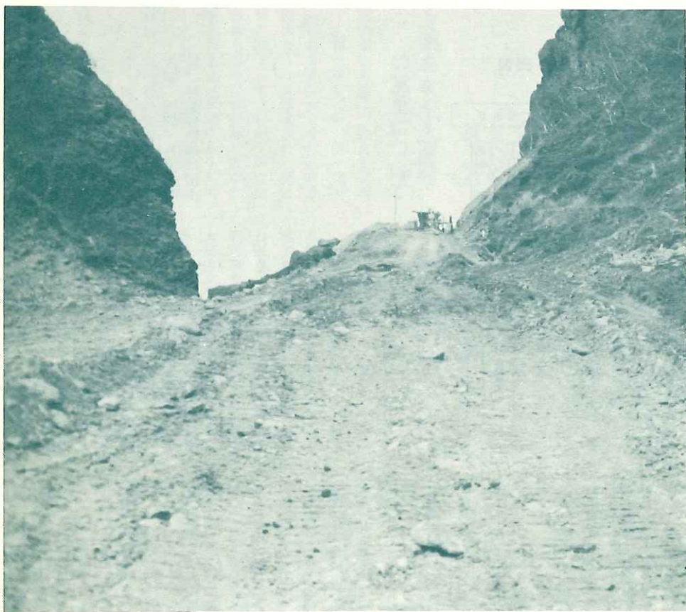
改良工事進む青苗～神威協間道路
