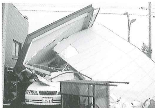
▲倉庫が全壊し、隣にあった自動車をも押しつぶす
