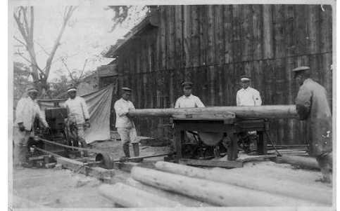
架橋演習時に於ける製材作業
