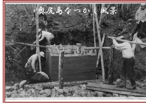
青苗簡易水道敷設工事 昭和31年
