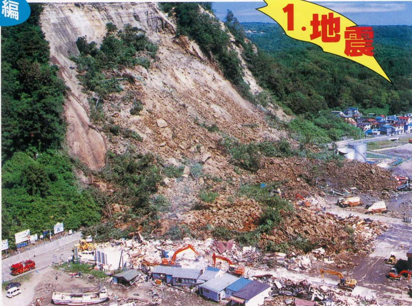
▲地震発生直後、大規模な崖地の崩壊により、ホテルとレストラン、灯油備蓄タンクが一瞬のうちに飲み込まれ、29名の尊い命が犠牲となった奥尻地区 (朝日新聞社提供)
