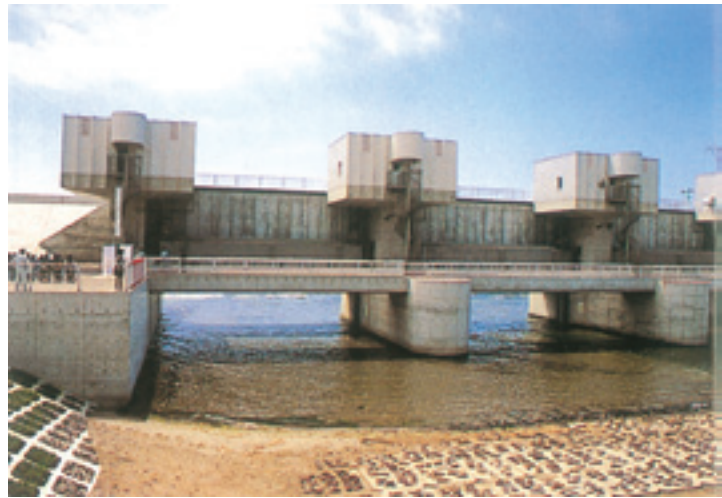
▲津波対策として設置された青苗川水門
