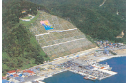
▲崩壊した崖地は大壁画とともに蘇った
