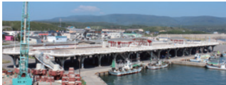
▲青苗漁港人工地盤の全景
