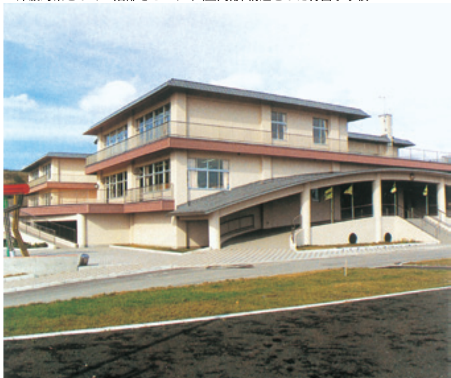
▼津波対策として1階部をピロティ（空間部）構造とした青苗小学校
