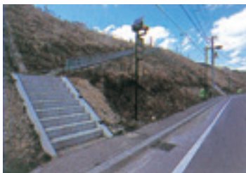
緊急時の避難路も整備された
