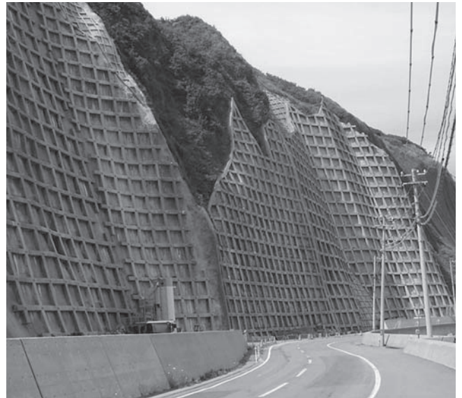
▲宮津～勤太浜間で行われている崩落防止工事
