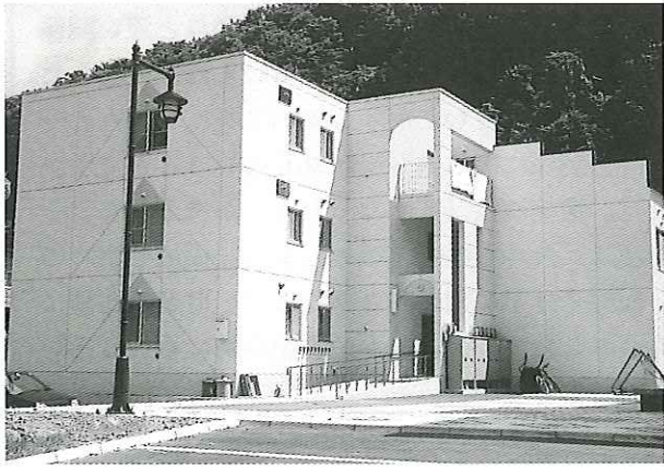
▲ 簡易保険の融資で建てられた塩釜団地公営住宅
